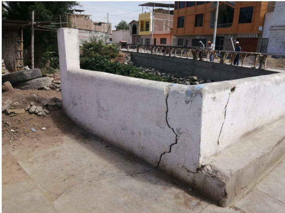
**FOTO 05:** Muro con presencia de rajaduras bastante pronunciadas
