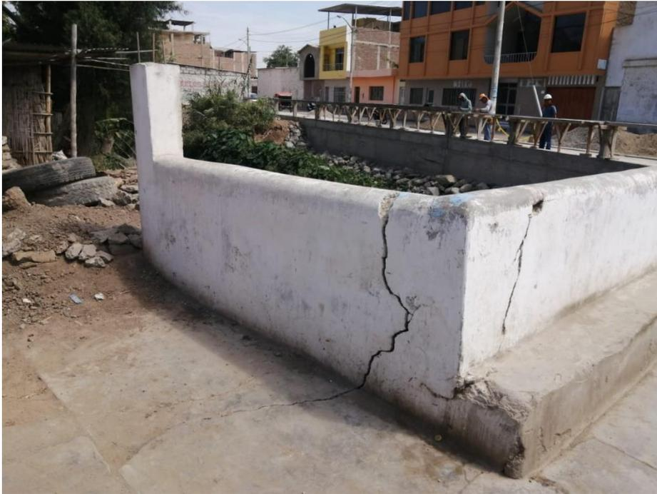
**FOTO N° 04:** Vista de muro lateral izquierdo del pontón, con acercamiento hacia las grietas más importantes.
