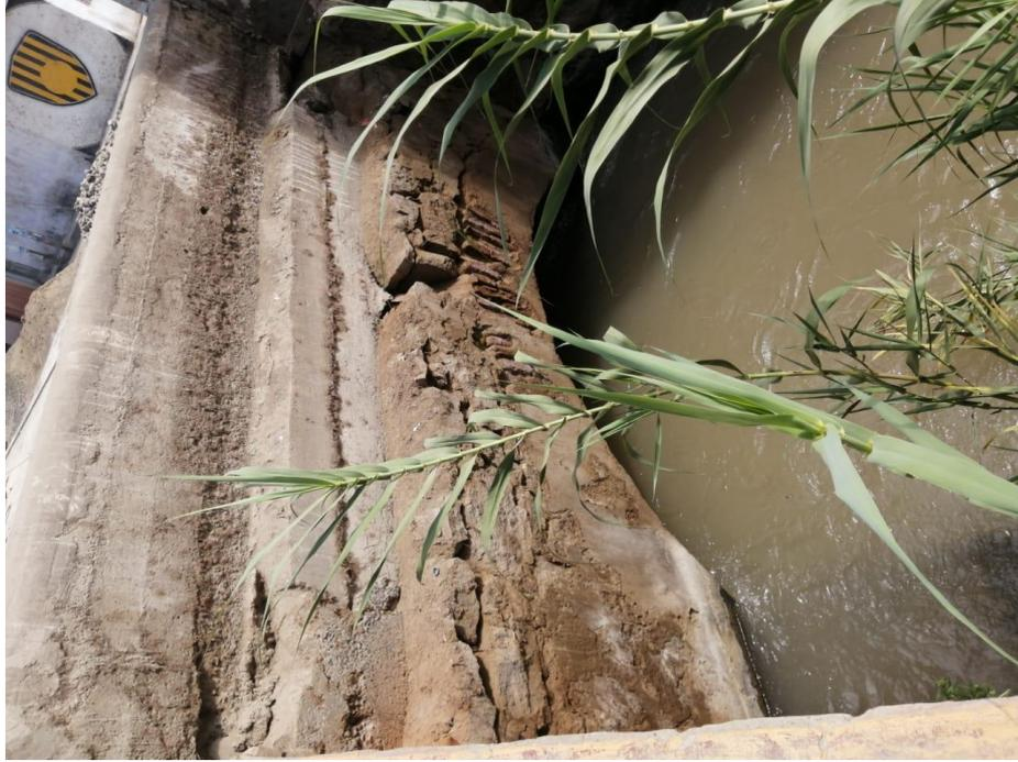
**FOTO 09:** Puente existente deteriorado
