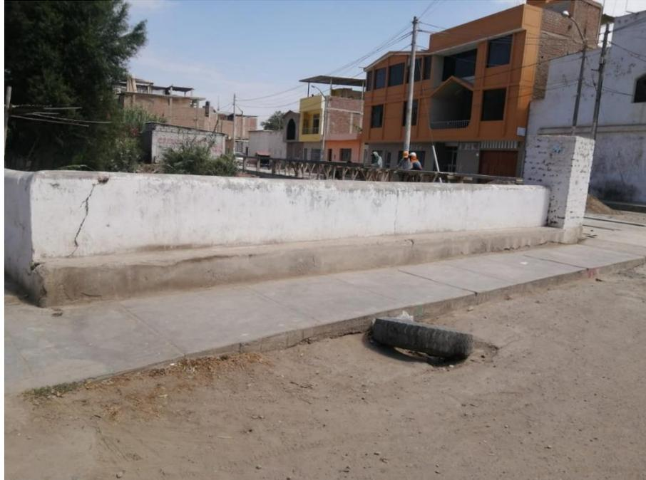
*FOTO N° 01: Parte superior del Pontón La Bóveda. Se aprecia el estado de la losa del puente. Presencia de material de arrastre.*
